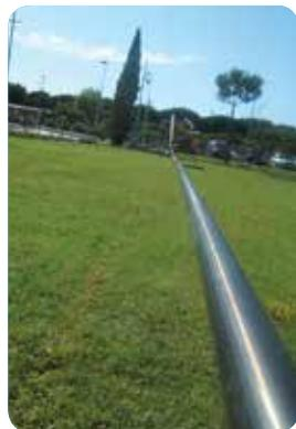
La società si è specializzata nelle perforazioni orizzontali a guida controllata (T.O.C.) - un sistema che permette di installare le tubazioni delle varie infrastrutture senza l'apertura degli scavi.
